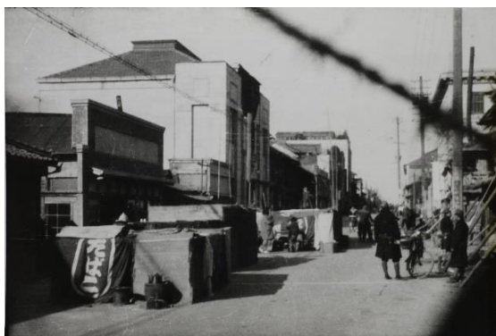
地震小屋の並ぶ中央通り
